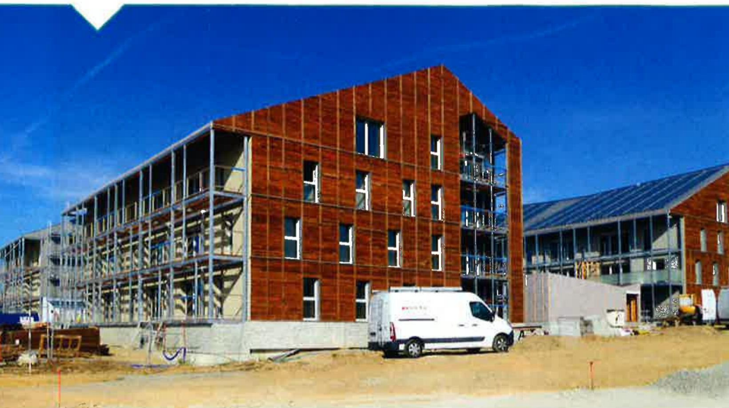
Les bâtiments Tempo en cours de finition.
